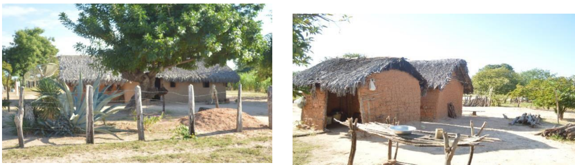
Figura 2. Casas de moradores da comunidade Tabatinga. As casas construídas de taipa e a utilização de palhas na cobertura refletem a história de constituição desses quilombos.
