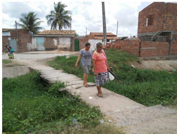
Figura 2 - Pontilhão sobre o canal de drenagem
