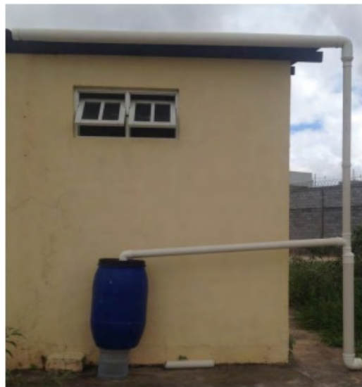
Figura 3 - Dispositivo para desvio da primeira água em um sistema de captação de água da chuva
