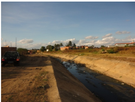
Figura 3 - Imagem do canal de drenagem
