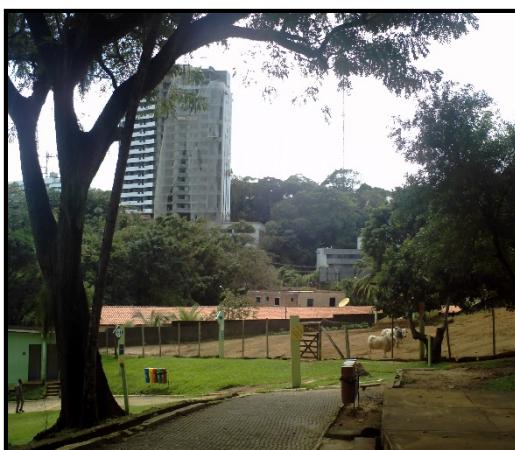
Figura 6 - Edifício em construção próximo ao PZGV
