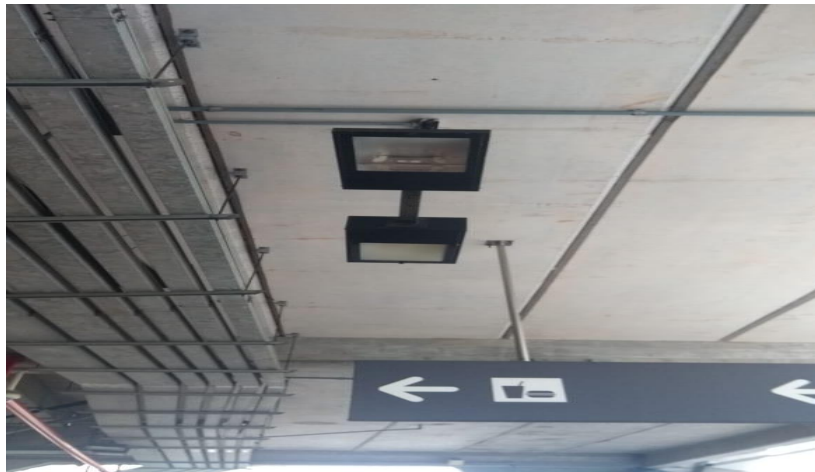
Figura 7 - Lâmpada e telhado
