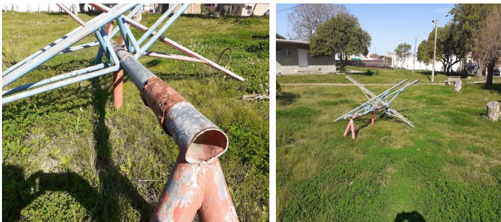
Figura 7 - Praça José Carlos Gonçalves – gangorras quebradas e enferrujadas.
