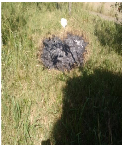
Figura 12 - Praça Rotary – indícios de depredação.
