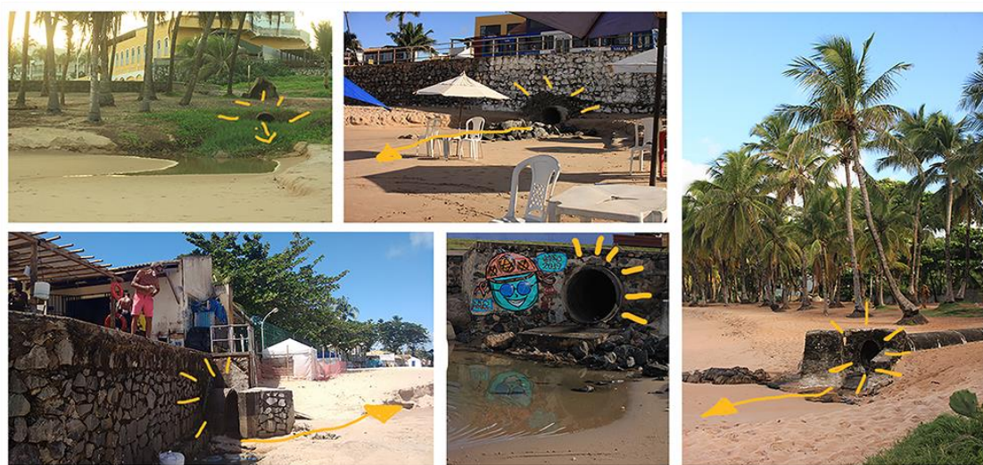
Rios canalizados desaguam na praia de Itapuã
