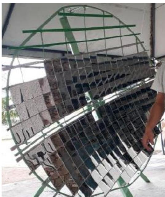
Figura 4. Processo final de fabricação do concentrador solar: instalação do material reflexivo.
