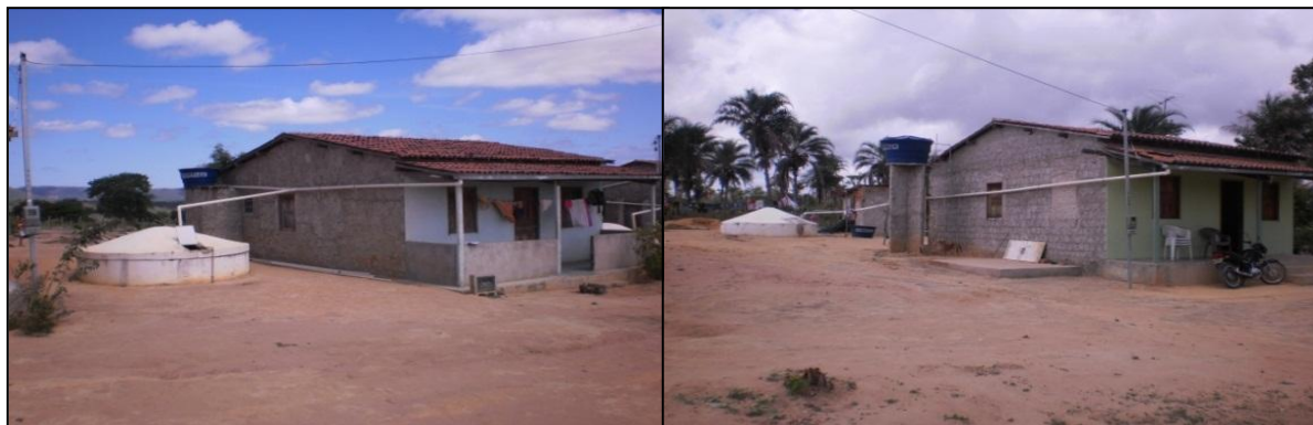
Figura 7. Sistema de captação de água pelo telhado no Assentamento Jiboia Agrovila I e II respectivamente em 2013.
