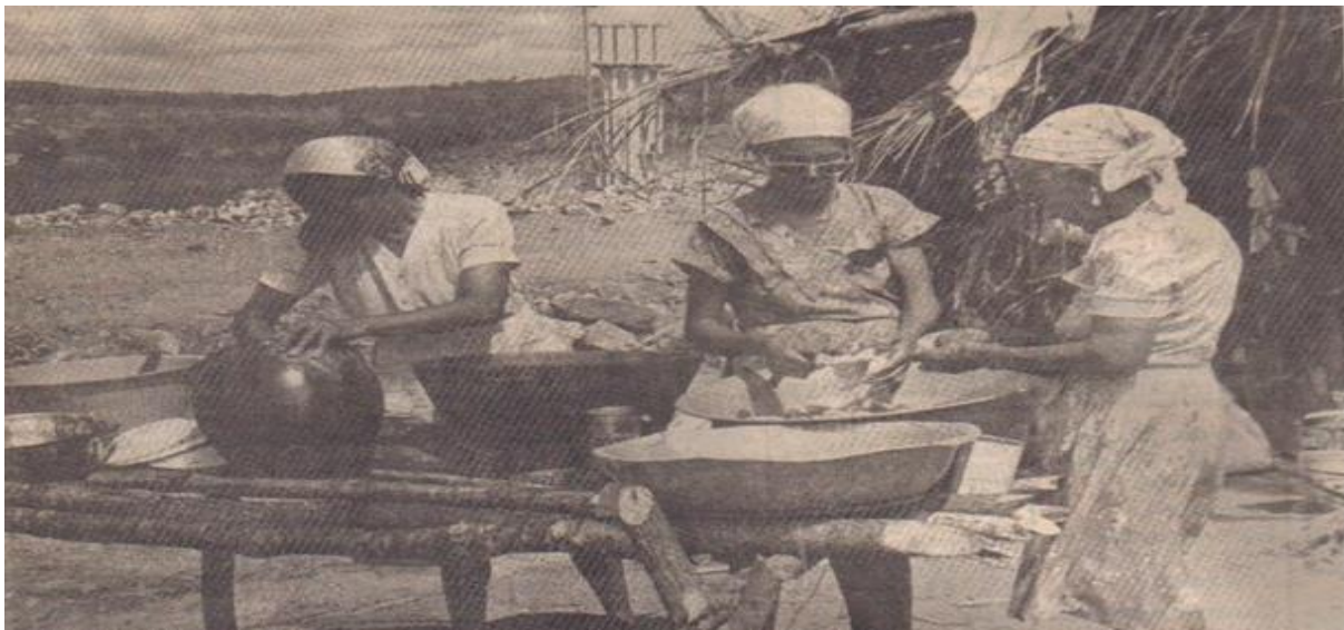
Figura 5 - Mulheres em atividades no canteiro de obras
