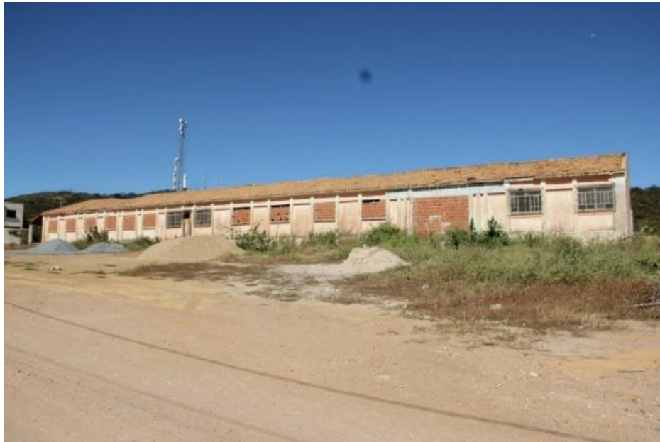
Figura 02: Fachada de frente do Ginásio D. Justino Russolillo
