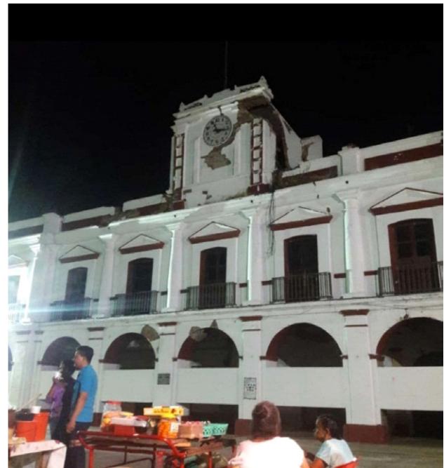
Figura 5 – Palacio de Juchitán afectado sismo 2017. Donde los muxes cuentan con su oficina para el atendimento de la comunidad
