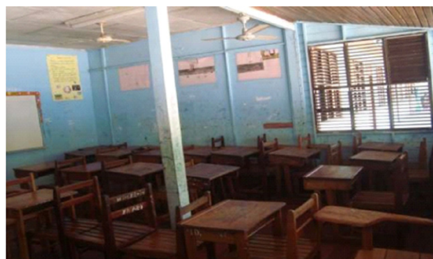
Figura 4 - Aspecto interno de uma das salas de aula da escola
