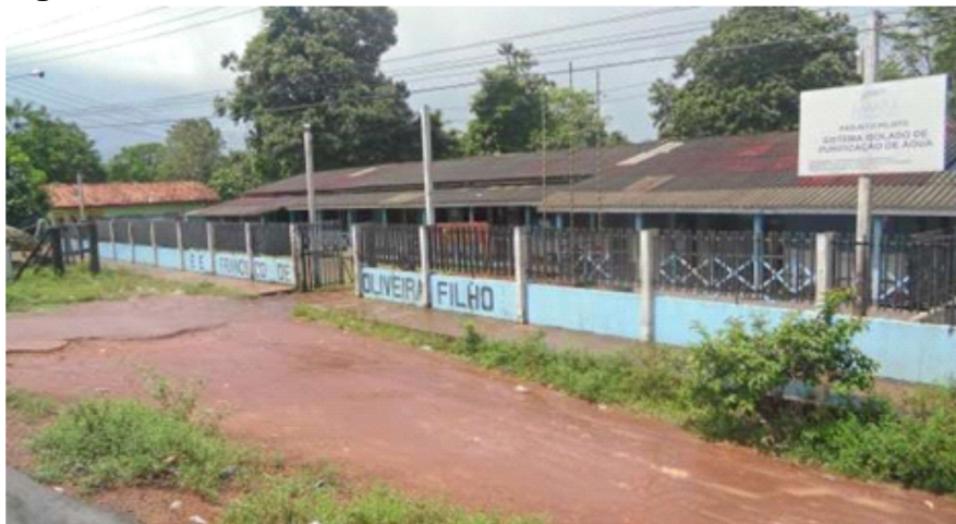
Figura 5 - Vista frontal da Escola Estadual Francisco de Oliveira Filho
