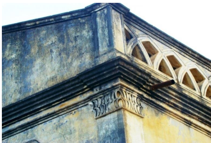
Figura X. Platibanda vazada em Juazeiro/BA Casa do Barão Enéas. Fonte: Arquivo pessoal Jackelina Kern
