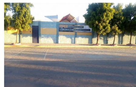
Figura 02: Fachada do prédio da Escola Municipal Colônia Agrícola de Ceraíma desde 2013.
