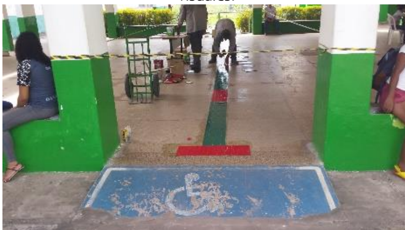
Figura 7 - Colocación de baldosas para facilitar la movilidad de los discapacitados visuales.
