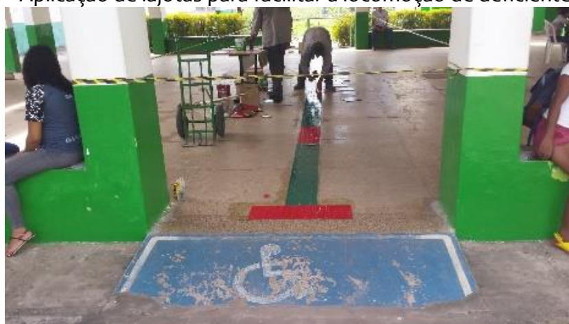
Figura 7 - Aplicação de lajotas para facilitar a locomoção de deficientes visuais.
