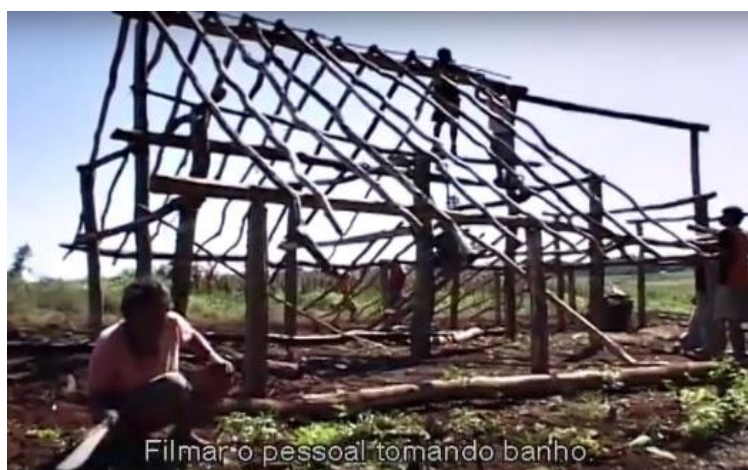
Figura 3 - Construção da Casa de Reza
