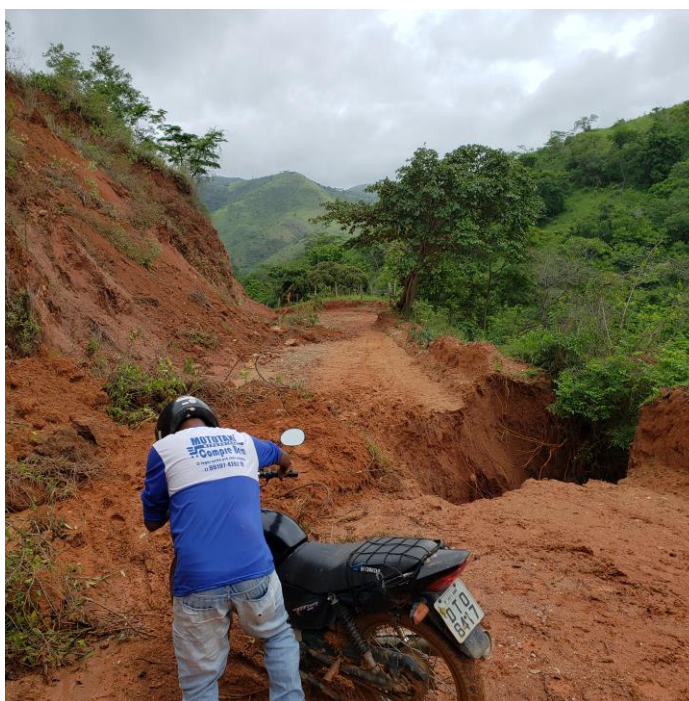
Fotografia 3: A Ladeira do Tinga, estrada vicinal de acesso à comunidade depois de uma chuva 12 .
